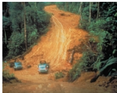
L'aménagement de nouvelles pistes ouvre l'accès aux forêts jusqu'ici inexploitées.
